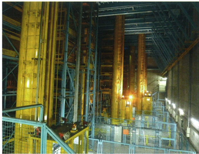
Bei den Regalförderzeugen im Box-Storage-System wurde ein Upgrade des Positioniersystems durchgeführt
