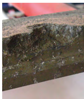
Unten links: Beschädigung einer Schleifleiste (herausgebrochenes Fragment)
